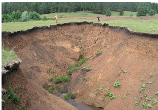
Рис. 5. Овраг на пойме р. Варзинка, возникший в результате прорыва двух земляных дамб прудов, расположенных в балке (2008 г.)
